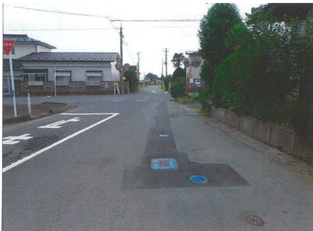
管路布設箇所
