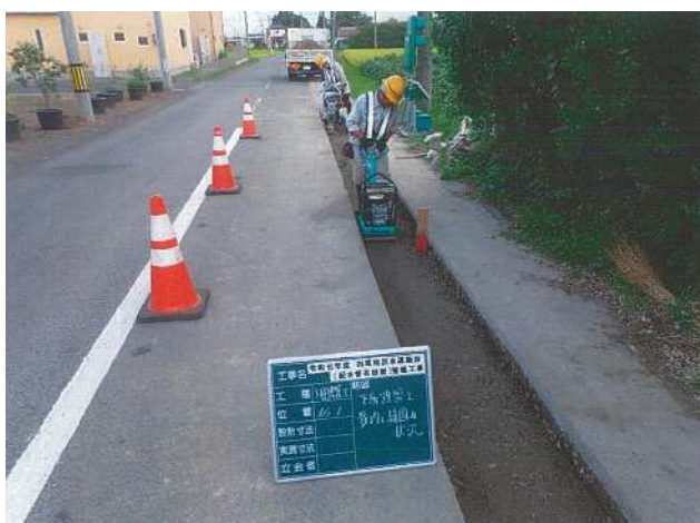
管路布設状況
