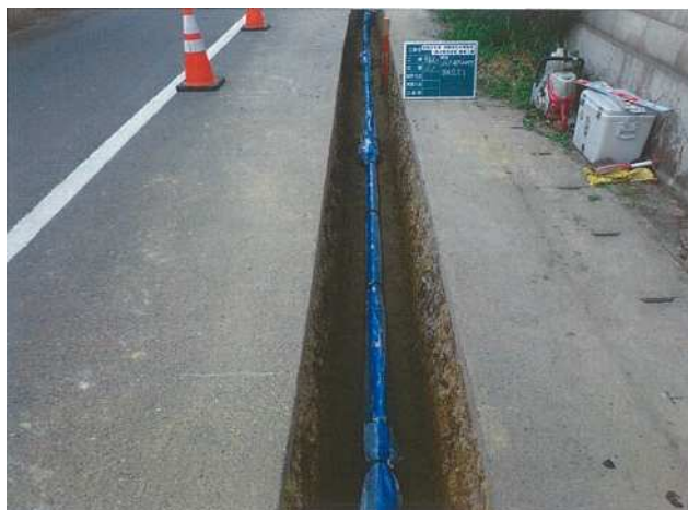
管路布設状況
