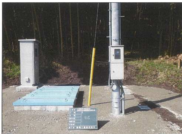
井戸設置状況
