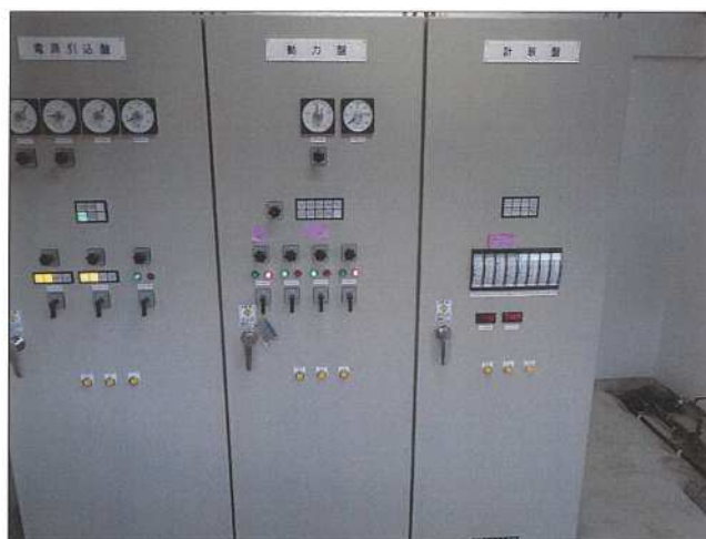
機械電気設備設置状況
