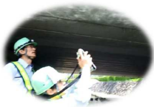
【タブレットによる点検】
