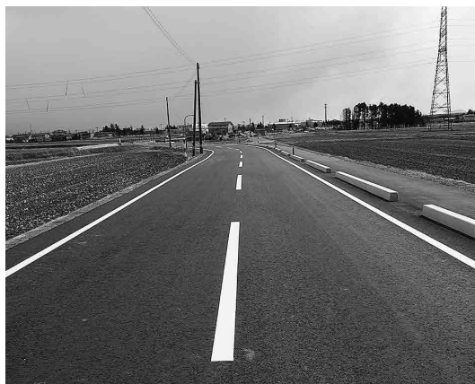
完成した加茂堂線
