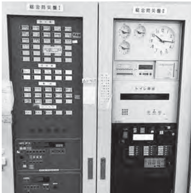
平沢交流センター火災受信機更新工事 1,046万1千円
