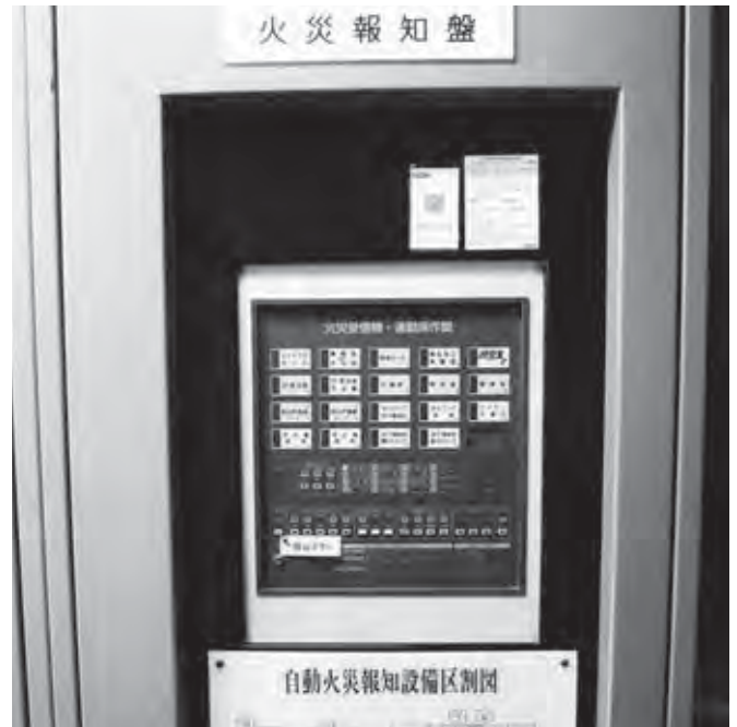
農業伝習館自動火災報知設備機更新工事 695万6千円
