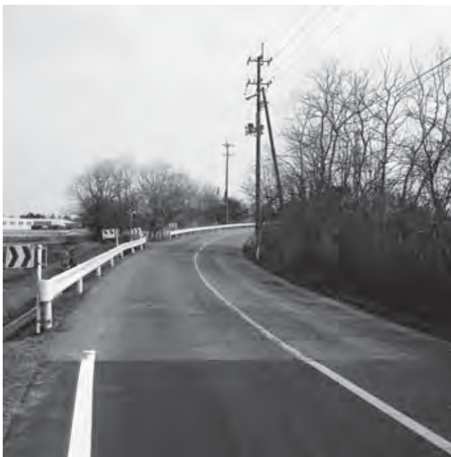
広域1号線舗装工事 7,891万1千円
