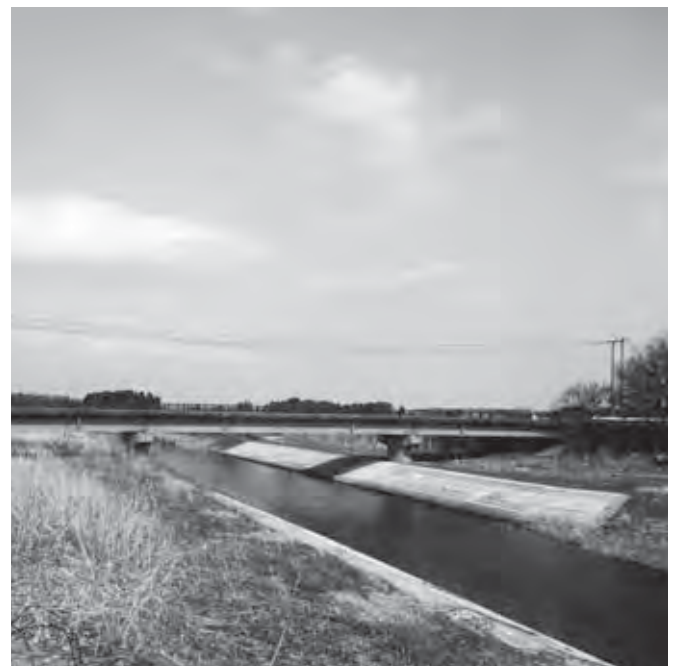
三字路橋修繕工事 2,400万円
