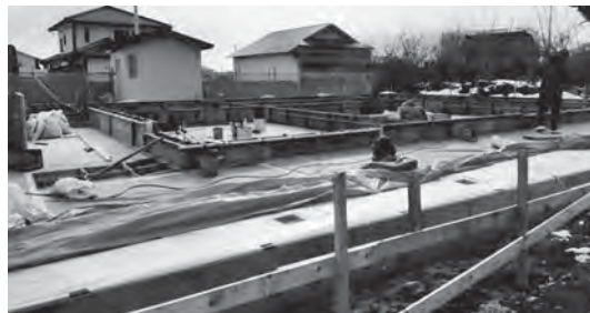
建設中の下高城集会所
