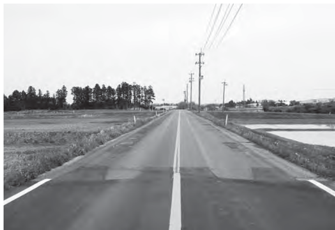
大原線舗装補修工事 2,612万円
