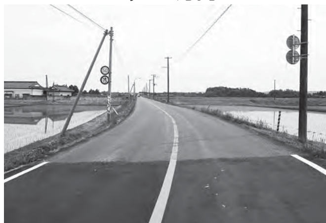
広域1号線舗装工事 6,750万円
