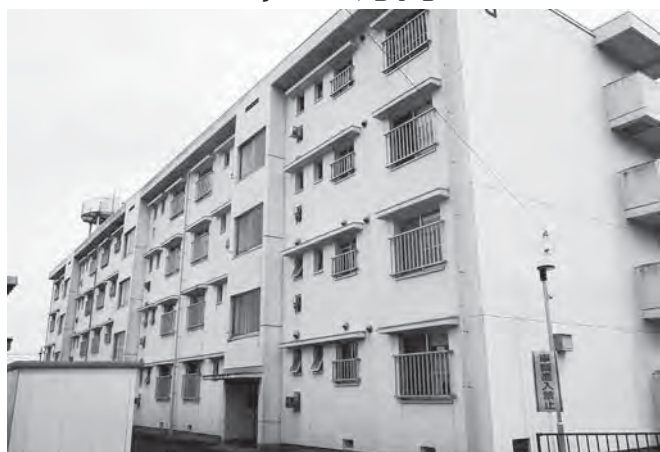
二反田住宅3号棟給排水管改修工事 1,500万円
