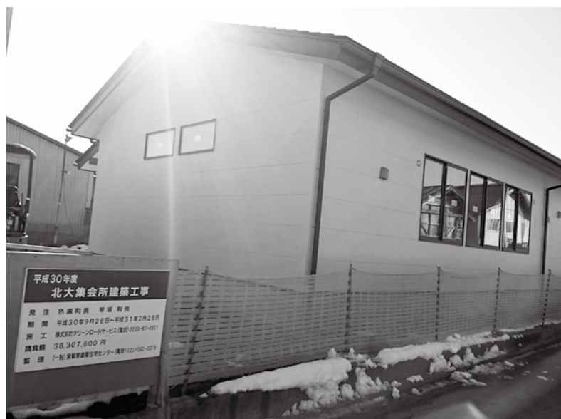
防衛交付金で建設中の集会所（北大）
