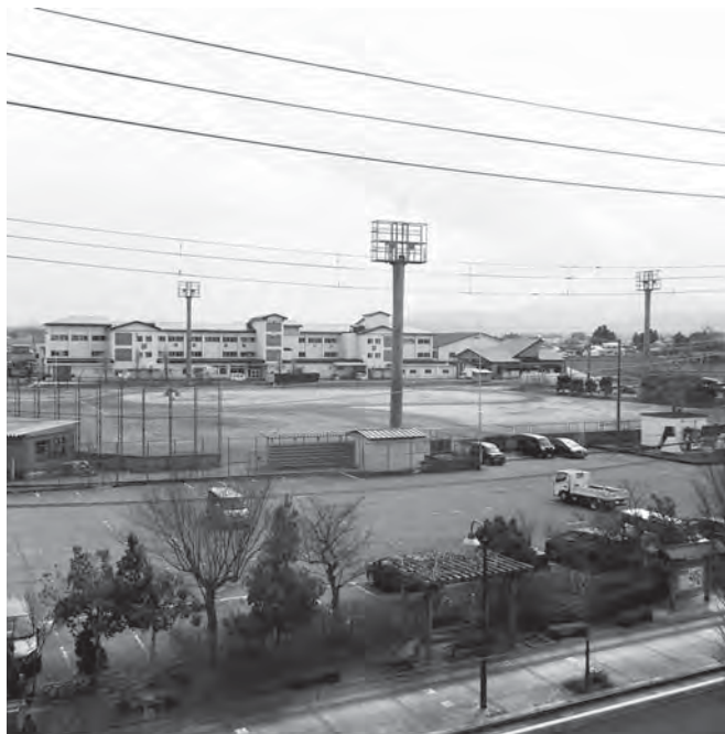
屋外運動場照明塔解体撤去工事 1,399万円
