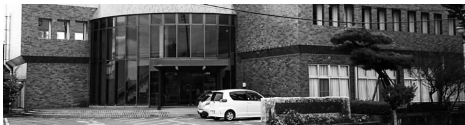
改修工事をした改善センター
