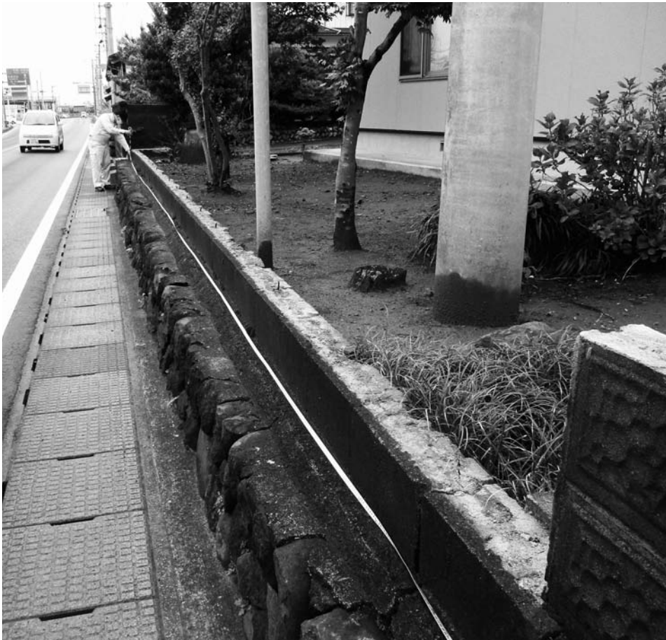
ブロック塀除却後
