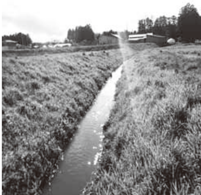
旧長谷川ほか用排水路整備工事
