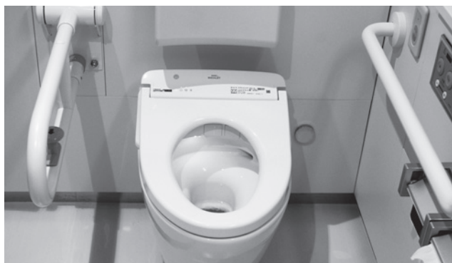
役場庁舎の多目的トイレ
