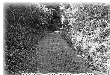
林道及び作業道の整備
